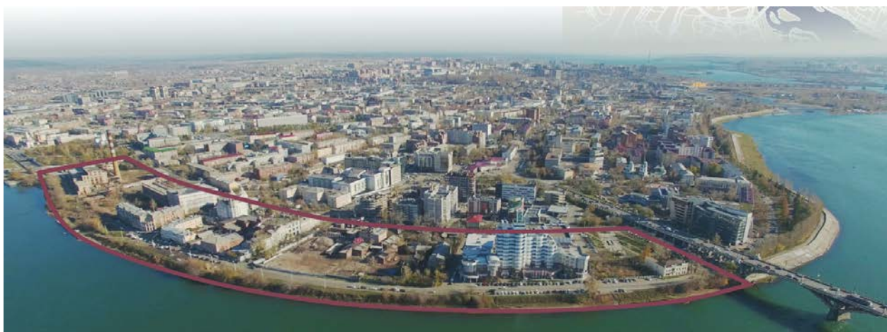
Рис.2 Существующее состояние (общий вид с воды) по площадке проектирования
