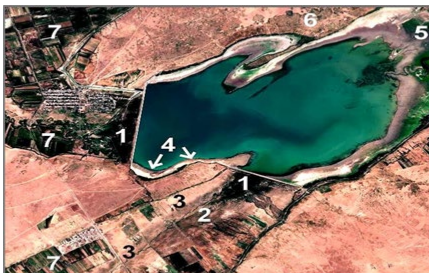
Рис.5. Влияние водохранилища на побережье: 1 – заболоченные засоленные почвы нижнего бьефа плотин; 2 – лугово-болотные и луговые засоленные почвы сая Каражантак; 3 – подтопленные лугово-сероземные солончаковые почвы; 4 – эрозионно-опасные участки побережья; 5 – подтопленные незасоленные почвы верховья водохранилища; 6 – слабо подтопленные светлые сероземы с крупнотравной растительностью; 7 – орошаемые земли (снимок Сентинел-2 за 19.07.2019)
