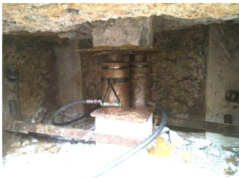
Рисунок 2 - Фрагмент випробування ґрунтів палею з під ростверку
