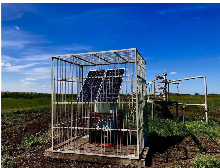
Рисунок 1 – Загальний вигляд капілярної колтюбінгової установки
